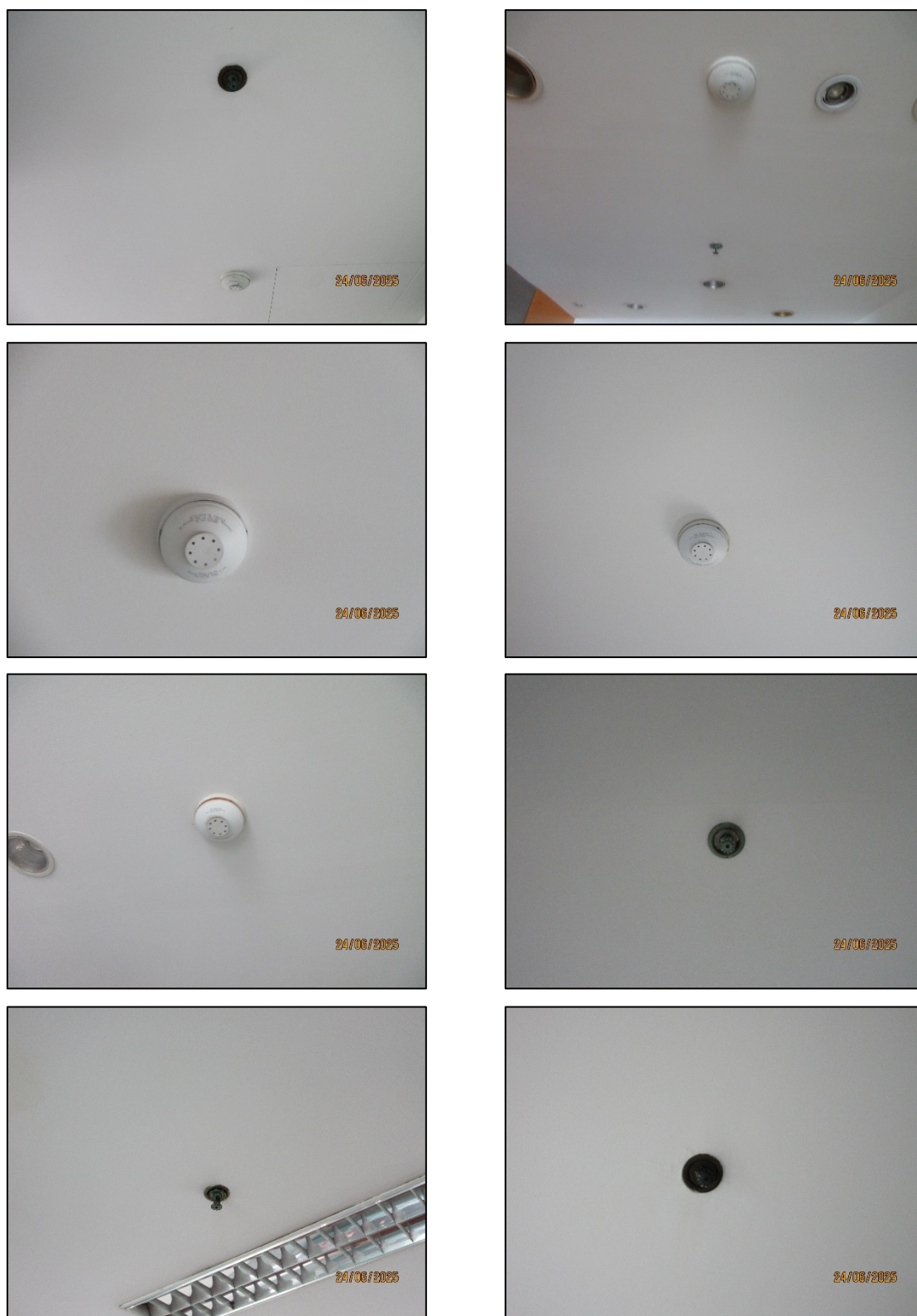
รูปที่ 43 อุปกรณ์ตรวจจับควัน / ตรวจจับความร้อน
